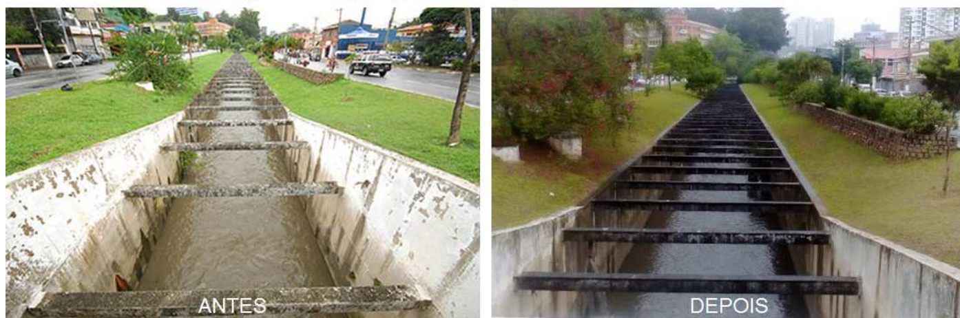
Fig.C2 – Despoluição do córrego Bussocaba - Osasco
