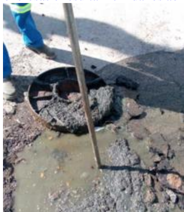
Figura 05 – Extravasamento de esgoto
