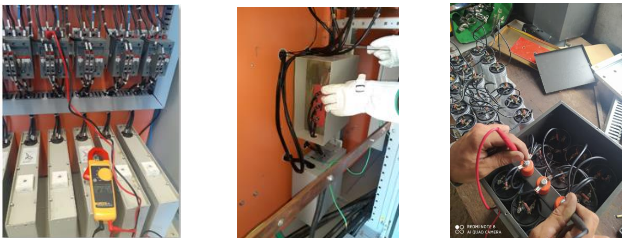
Figura 04 – Manutenção dos bancos capacitores
